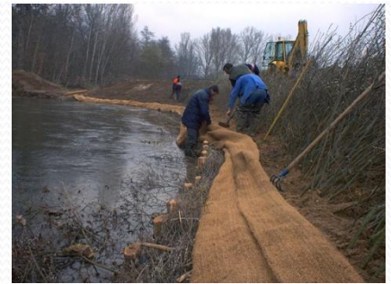
Chantier de stabilisation de berges
