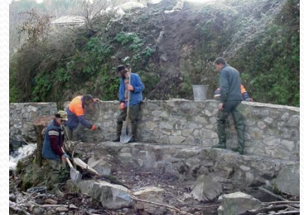
Chantier de maçonnerie sur le bief des Buriches sur l'Anzon
