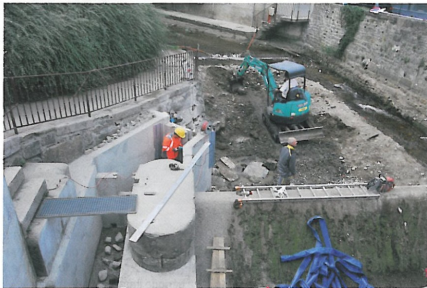
La passe à poissons a nécessité un mois de travaux sous le pont Saint-Jean. Elle est désormais opérationnelle.
