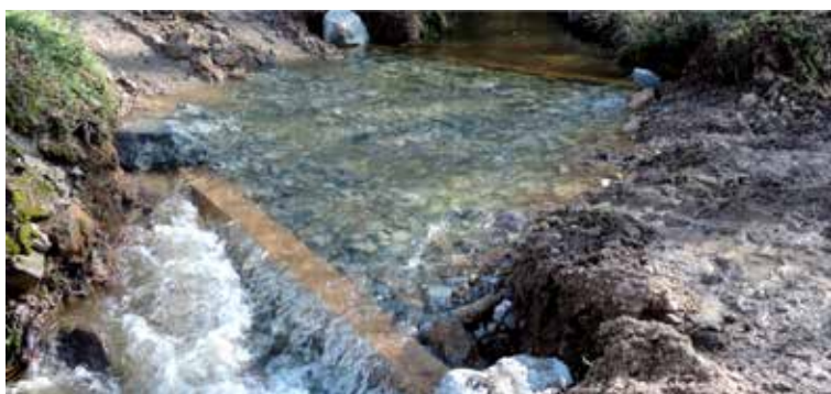
Réalisation d'un passage à gué après suppression d'un busage
