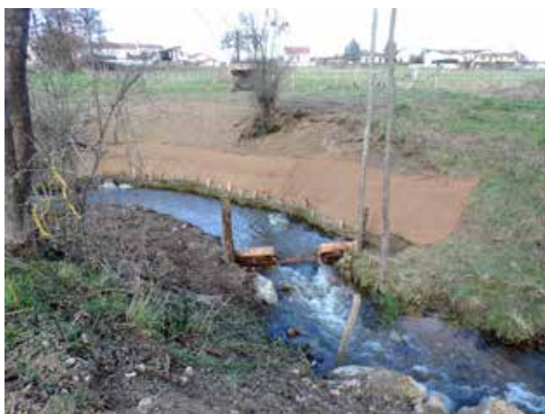
Stabilisation de berge en technique génie-végétal
