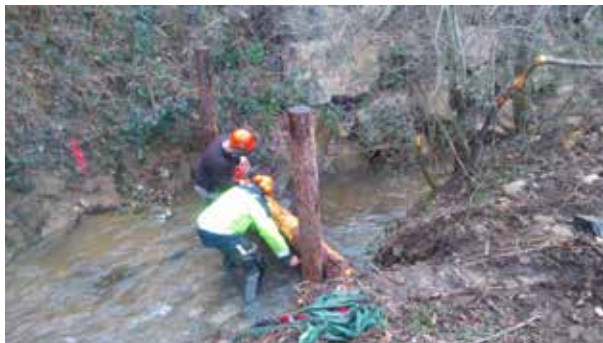
Mise en place d'un seuil de calage
