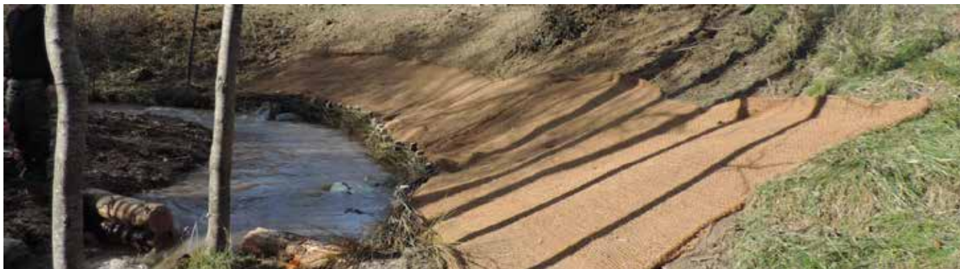
Réalisation d'un passage à gué après suppression d'un busage
