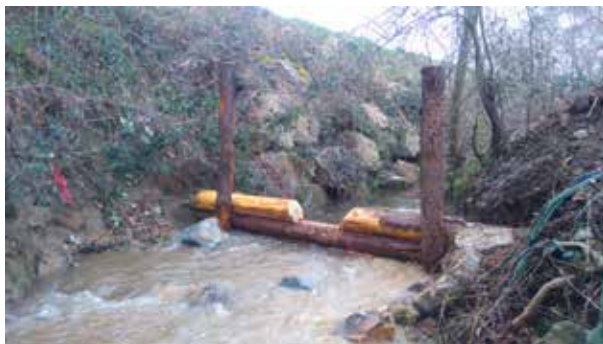
Mise en place d'un seuil de calage
