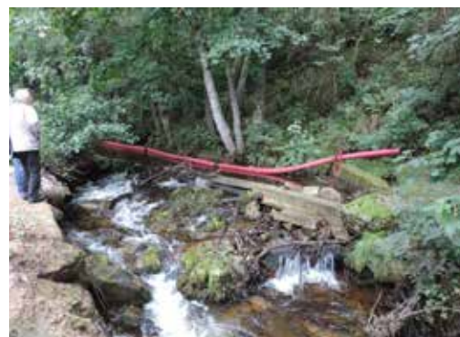
Arasement partiel du seuil - Chalmazel
