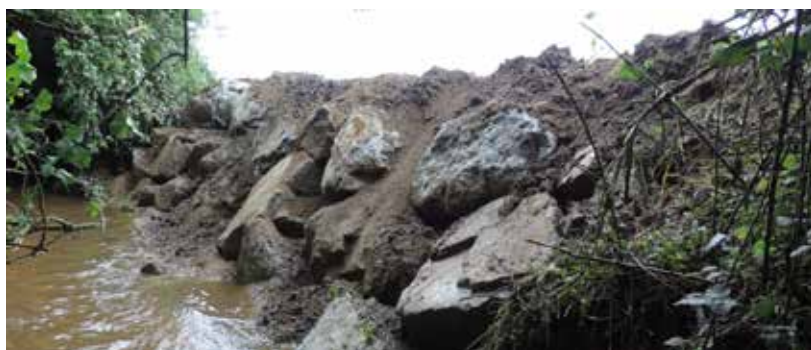
Réaménagement de l'enrochement sur le Félines à St Paul d'Uzore
